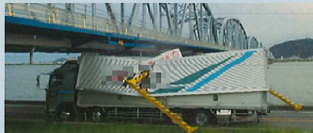
北詰アンダーパス事故(令和元年6月3日)
